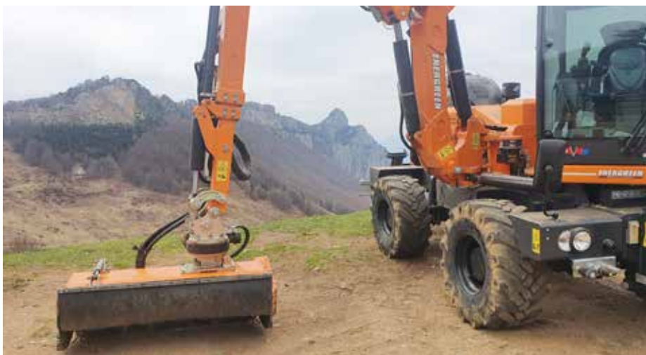
Impiego di mezzi meccanici per il ripristino del territorio.
