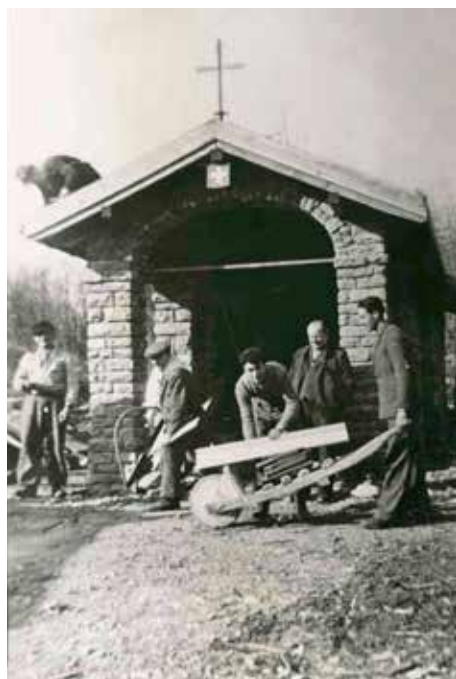
Inquadratura della cappella in costruzione. Da sinistra, sul tetto, Dante Peverelli; a terra: Natale Aspesi, Filippo Ortelli, Felice Zappa, Gino Ghielmetti e Antonio Doninelli (foto Antonio Doninelli).
